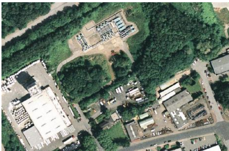
Abbildung 2: Grubengasanlage nahe der Energiesenke
